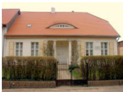
In diesem Haus in Köthen wohnte Eichendorff von April bis Oktober 1855
